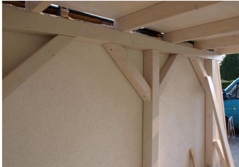
Pro freistehendem Standpfosten sind zwei Kopfbänder vorgesehen. Bei einem Geräteraum werden innerhalb des Geräteraumes keine Kopfbänder angebracht.
