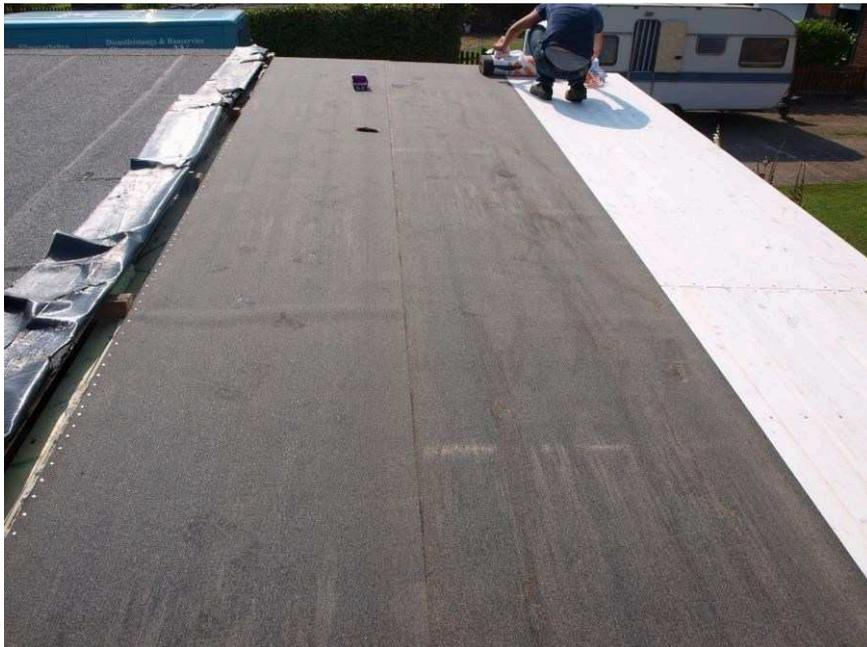
Bitte beachten Sie, dass die Gesamtlänge und -breite der Dachpappe ungefähr 10 cm länger als das Dachmaß ist, damit diese Überlänge dann, mittels dem Klemmprofil, in die umlaufende Alublende befestigt werden kann
