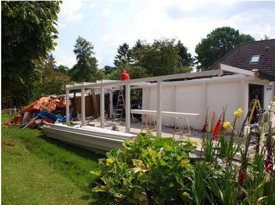
Der lichte Sparrenabstand beträgt in der Regel zwischen 66-74 cm, je nach Carportlänge, Sparrenstärke und Aufbauort. Der genaue Abstand wird durch die beiliegenden Wechsel vorgeben.
