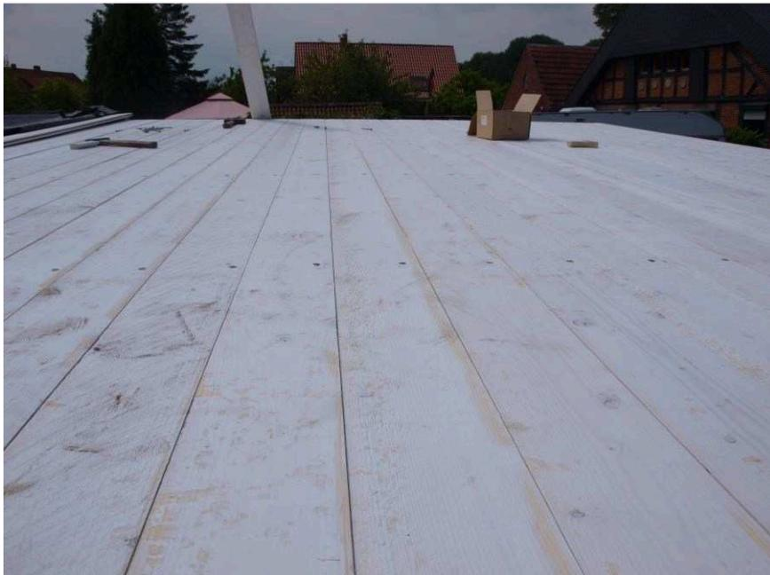
Es kann sein, dass der Rauhpund in Teillängen geliefert wird. Dann ist darauf zu achten, dass der Stoß auf einem Sparren liegt und dieser nicht ohne Auflagepunkt erfolgt.
