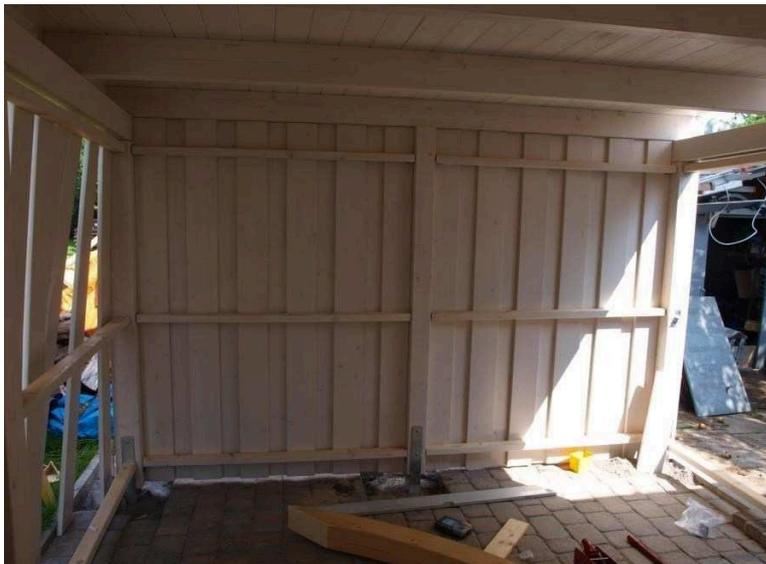
Bei der Holzausführung Fichte, werden Nut+Federbretter, 19x96 mm geliefert, die dann ebenfalls mit jeweils 6 Schrauben/Brett an den 3 Querriegeln befestigt werden.
