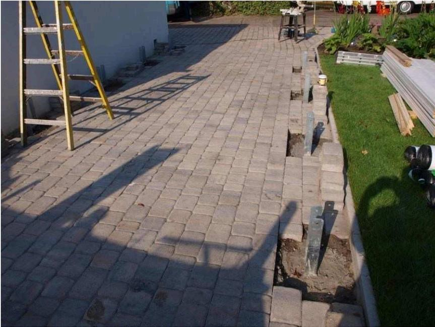
Die Ausrichtung der H-Pfostenträger verläuft so, wie Sie anschließend die Pfosten gut und einfach befestigen können.
