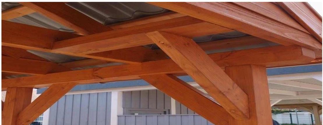
Die Querkopfbänder werden ebenfalls mit je einer Holzbauschraube, 8,0x160 mm pro Auflagepunkt an dem Standpfosten und dem Wechsel befestigt.
